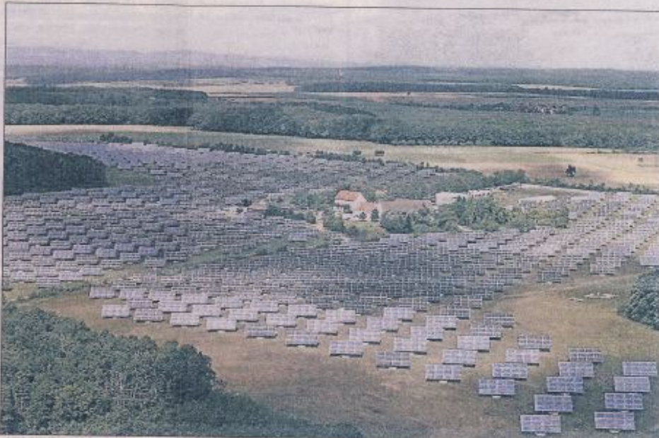
Solar satt mit Zukunftsperspektive: Der Solarpark Gut Erlasee bei Arnstein hat eine Gesamtleistung von zwölf Megawatt und eine Produktion von 14 000 Megawattstunden pro Jahr. Fotos: dpa, Breuer
