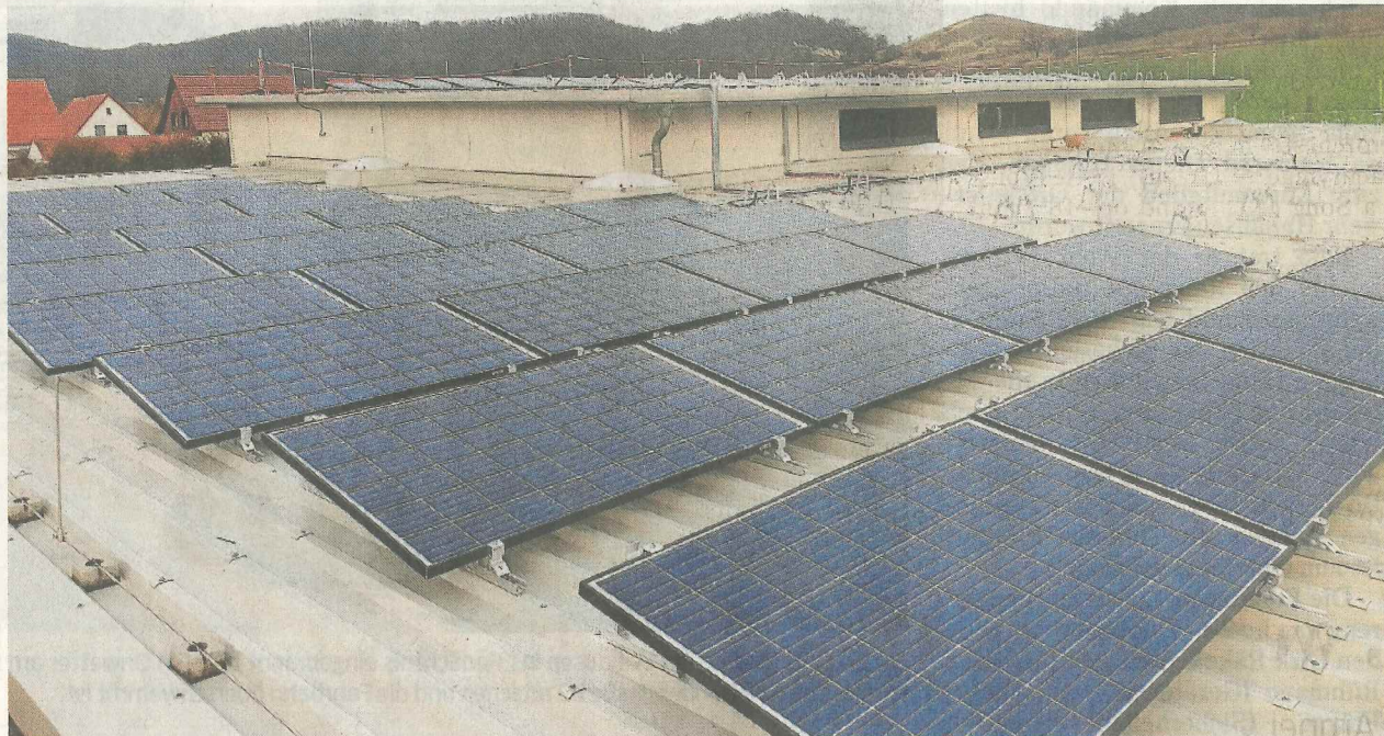
Die rund 700 Quadratmeter Dachfläche des neuen Othfresener Feuerwehrgerätehauses werden jetzt mit einer Photovoltaikanlage für das erste Projekt der Bürgerenergiegenossenschaft genutzt.
