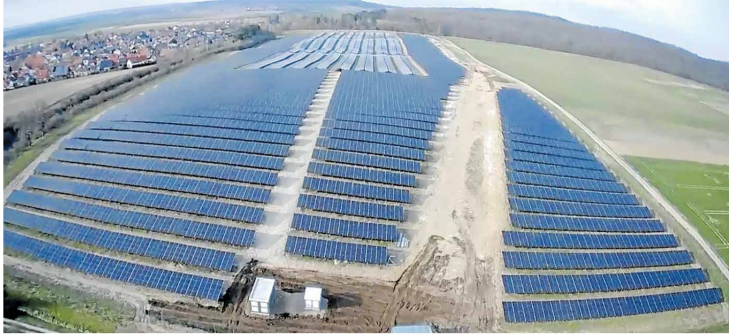
Die Drohnenaufnahme zeigt die Dimension des Solarparks, der sich auf einer Fläche von 11,5 Hektar östlich von Dörnten erstreckt. Foto: Privat
